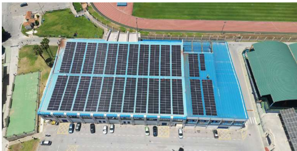
Piscina olímpica municipal, Torremolinos
