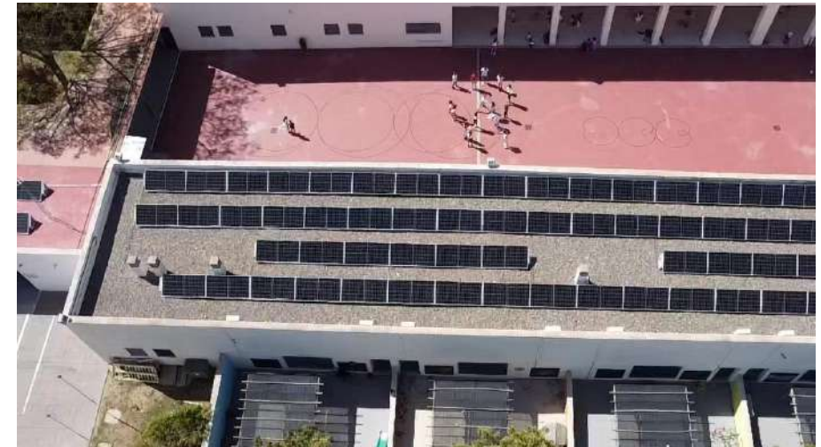
Colegio municipal, Torremolinos
